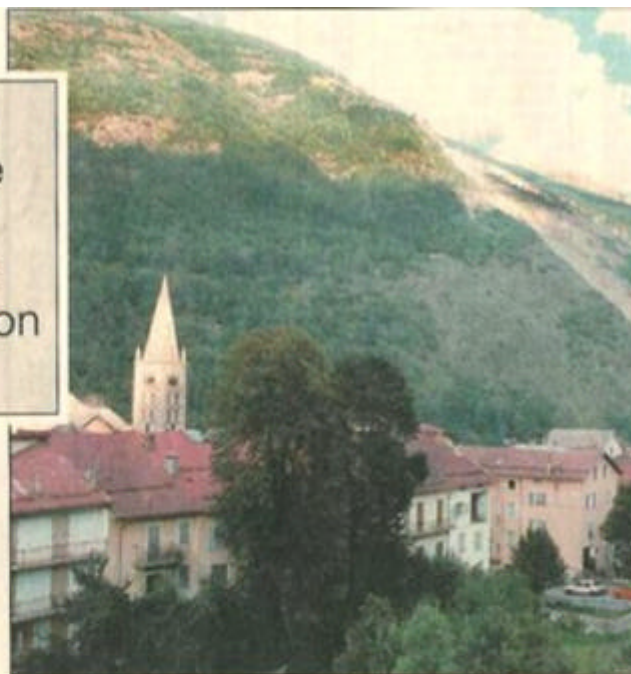
La Clapière devrait continuer à avancer et à remplir le fond de vallée sans
